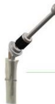
Mise en place du double cône
